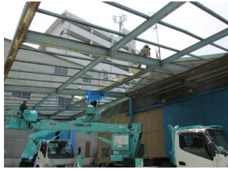
解体工事のようす
