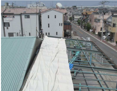
新しいテント屋根を設置するようす
