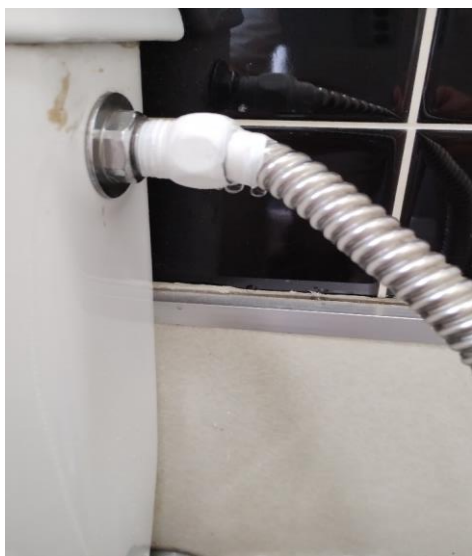
漏水水道管の修理
